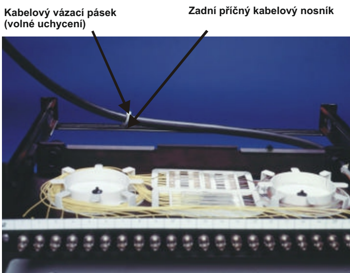
Fixace kabelu na zadní příčný kabelový nosník
