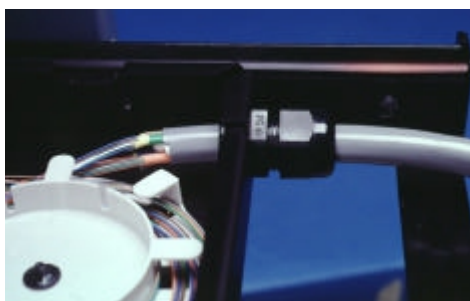
Nainstalovaná průchodka s kabelem
