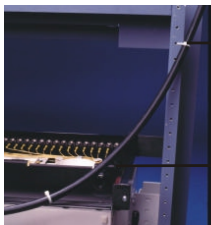
Fixace kabelu ke stojanu
